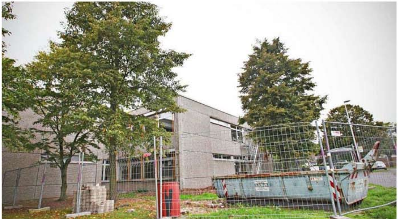
Der Umbau der Henri-Dunant-Schule in Delrath zu einem Lernort wurde zu einem Dauerbrenner. Foto: LH
